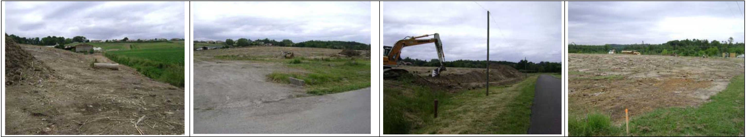
Préparation du chantier - Juin 2010
