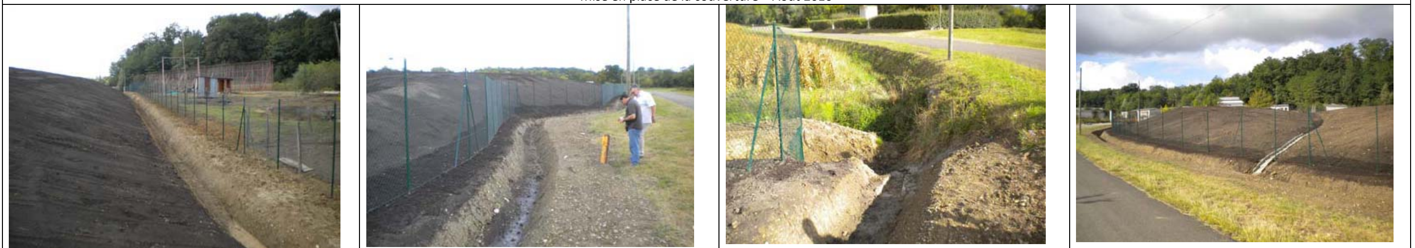
Mise en place de la terre végétalisable, Clôture du site – Septembre 2010
