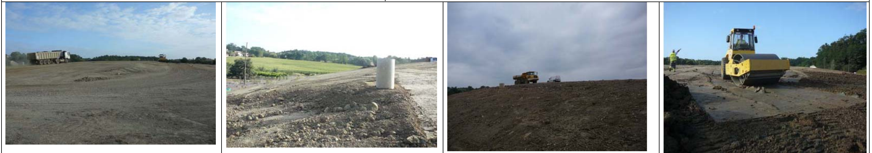
Mise en place de la couverture – Août 2010
